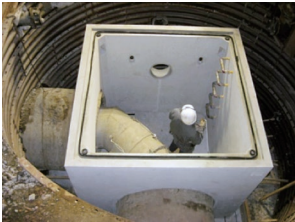
割り込み人孔 (基礎部現場打ち)
