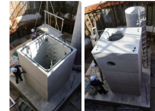
下部現場打の上部工
