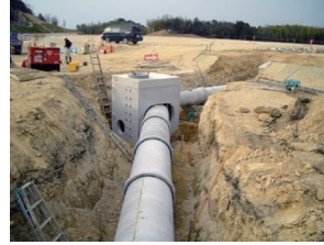
ヒューム管接続
