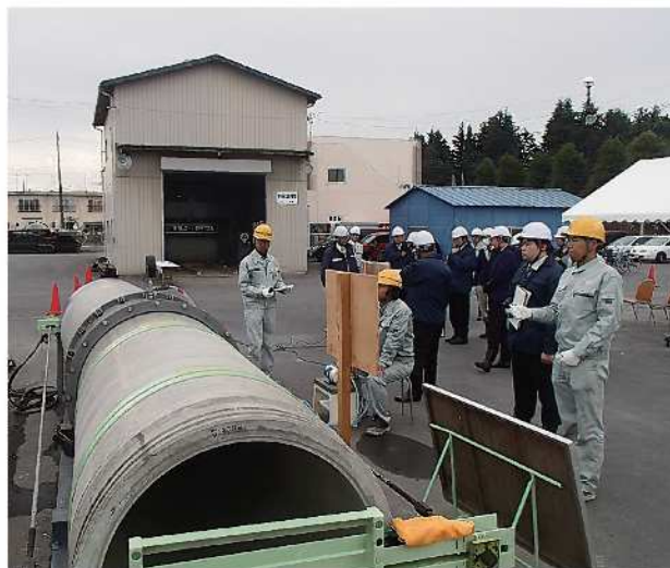
最大拔出し長確認状況
